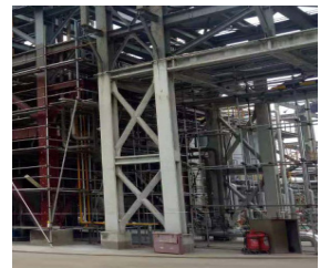
室外钢结构防火系统 (FP-WH 室外非膨胀型钢结构防火涂料)
