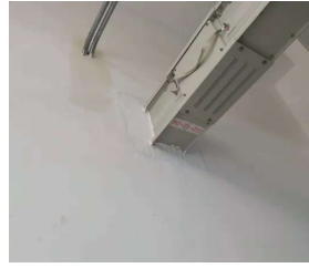
母线穿墙防火封堵 (FB-1 防火涂层板系统)
