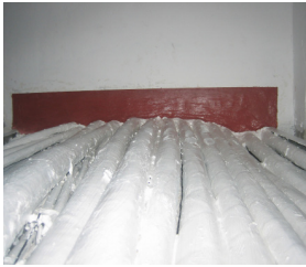
电缆桥架穿墙防火封堵 (FC-1 防火灰泥系统)
