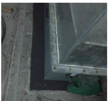
方形风管穿楼板封堵 (FS-H 高密度防火硅酮橡胶)
