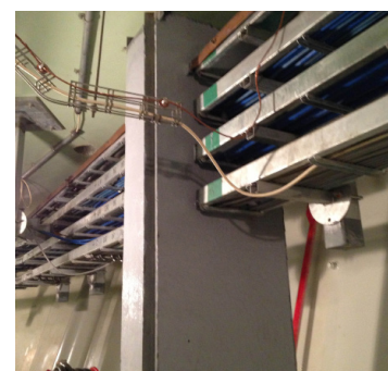
独立防火墙 (FS-L 防火硅酮泡沫 + FS-E 防火密封胶)
