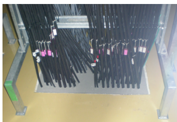
电缆穿楼板封堵 (FS-M 防火硅酮橡胶)
