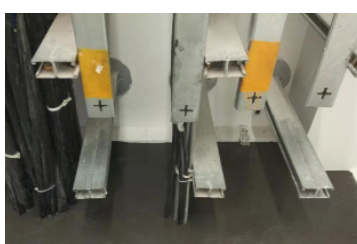
电缆桥架穿楼板 (FS-H 高密度防火硅酮橡胶)
