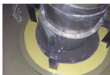
圆形风管穿楼板封堵 (FS-H 高密度防火硅酮橡胶)
