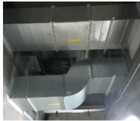
风管穿墙防火封堵封堵 (FB-1 防火涂层板系统)
