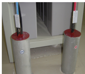
电缆管口防火封堵 (FS-I 防火密封胶)
