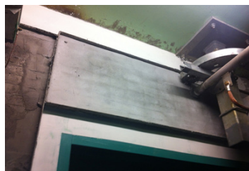
电缆穿墙防火封堵 (FC-1 防火灰泥)
