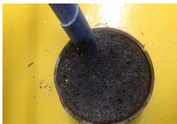
单根电缆穿墙防火封堵 (FS-L 防火硅酮泡沫)
