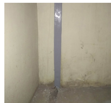
缝隙封堵 (FS-C 缝隙封堵材料)
